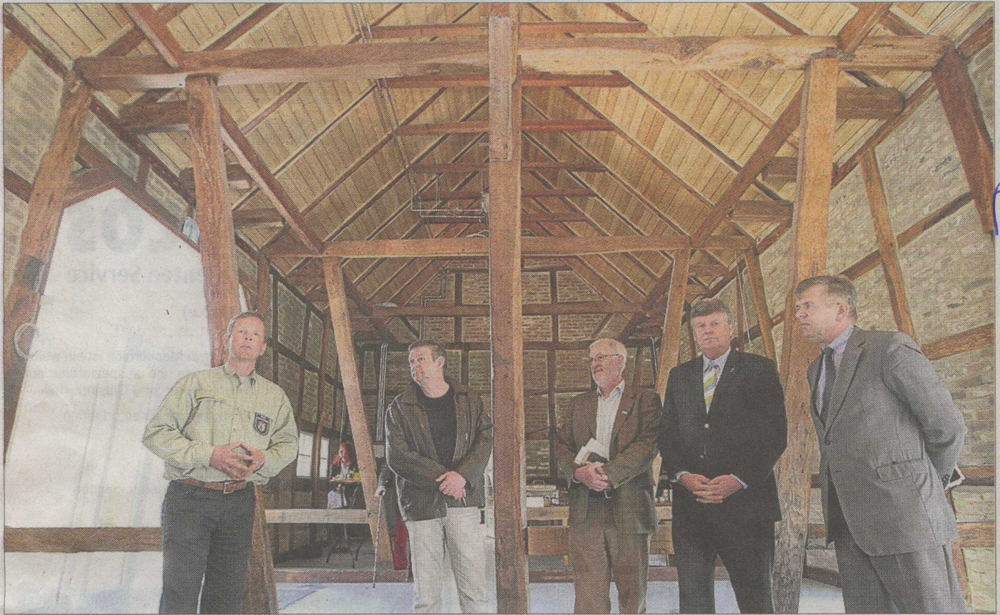
Großzügiger Raumeindruck im sanierten Altbau: Forstdirektor Jörg Fillmann (l.) mit Gästen, darunter Ex-RP Lindlar (2. v. r.).
