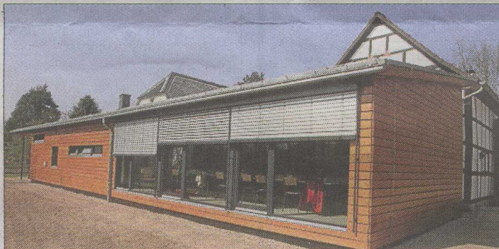
Ein moderner Anbau ergänzt das alte Forsthaus. (Fotos: Daub)
